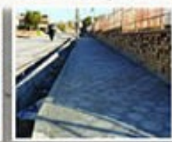
پیاده رو سازی محله وحدت آباد
